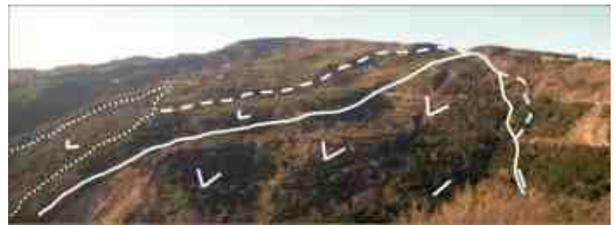
Fig. 1 – Panoramica della frana di Serra di Buda (da BORRELLI, 2008 mod).
