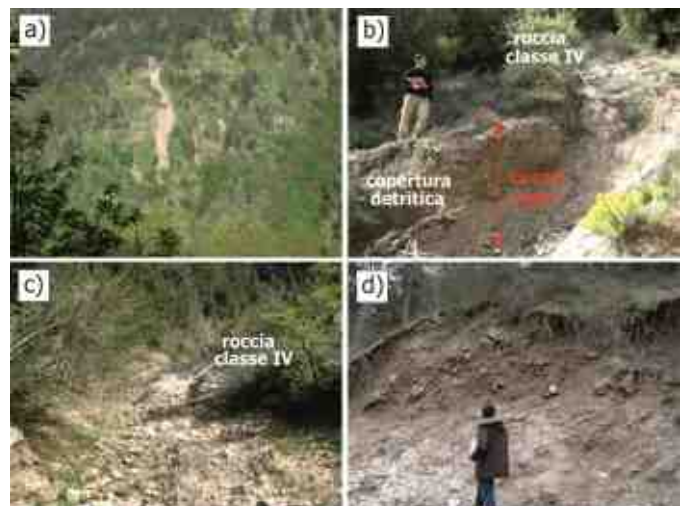
Fig. 2– Esempio di fenomeno franoso superficiale, di tipo scorrimento-colata di detrito: a) panoramica del fenomeno franoso; b) particolare della zona di innesco; c) particolare del canale di flusso; d) particolare della zona di accumulo.
