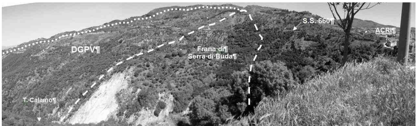
Fig. 1 – Panoramica della frana di Serra di Buda.
