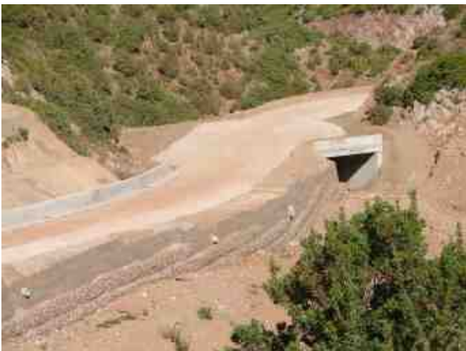
Fig.5 – Strutture flessibili del nuovo tracciato stradale
